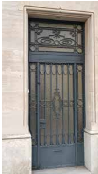
Porta auxiliar de la façana principal.
