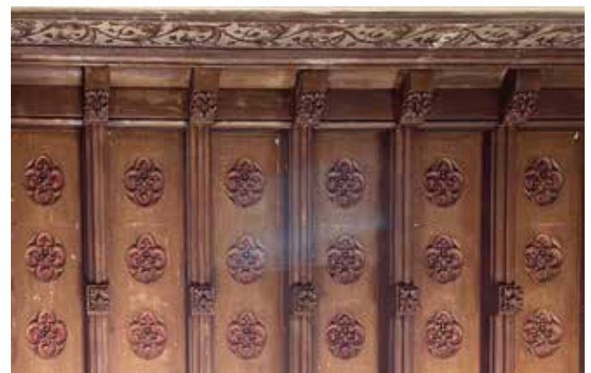
Detall del sostre enteixinat de la sala de pas de la primera planta.
