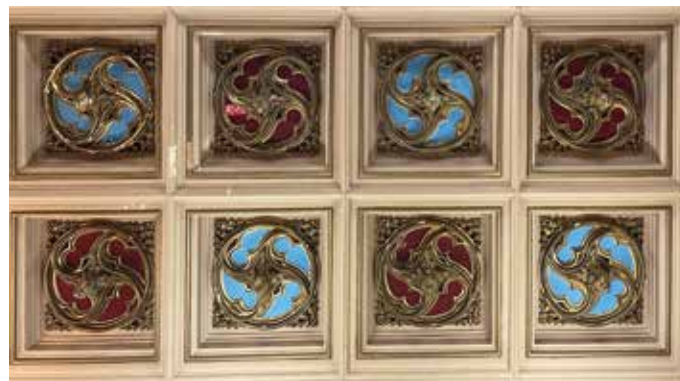
Detall del sostre pintat de l'antic gran saló de la casa, avui oficines de l'arxiu.
