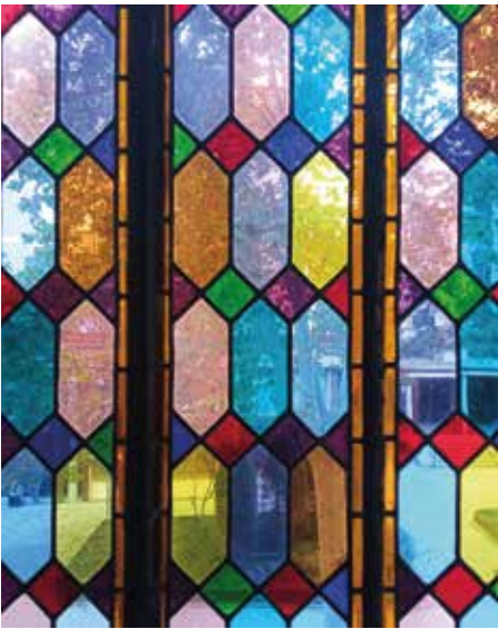
Detall dels vidres emplomats de la façana principal.
