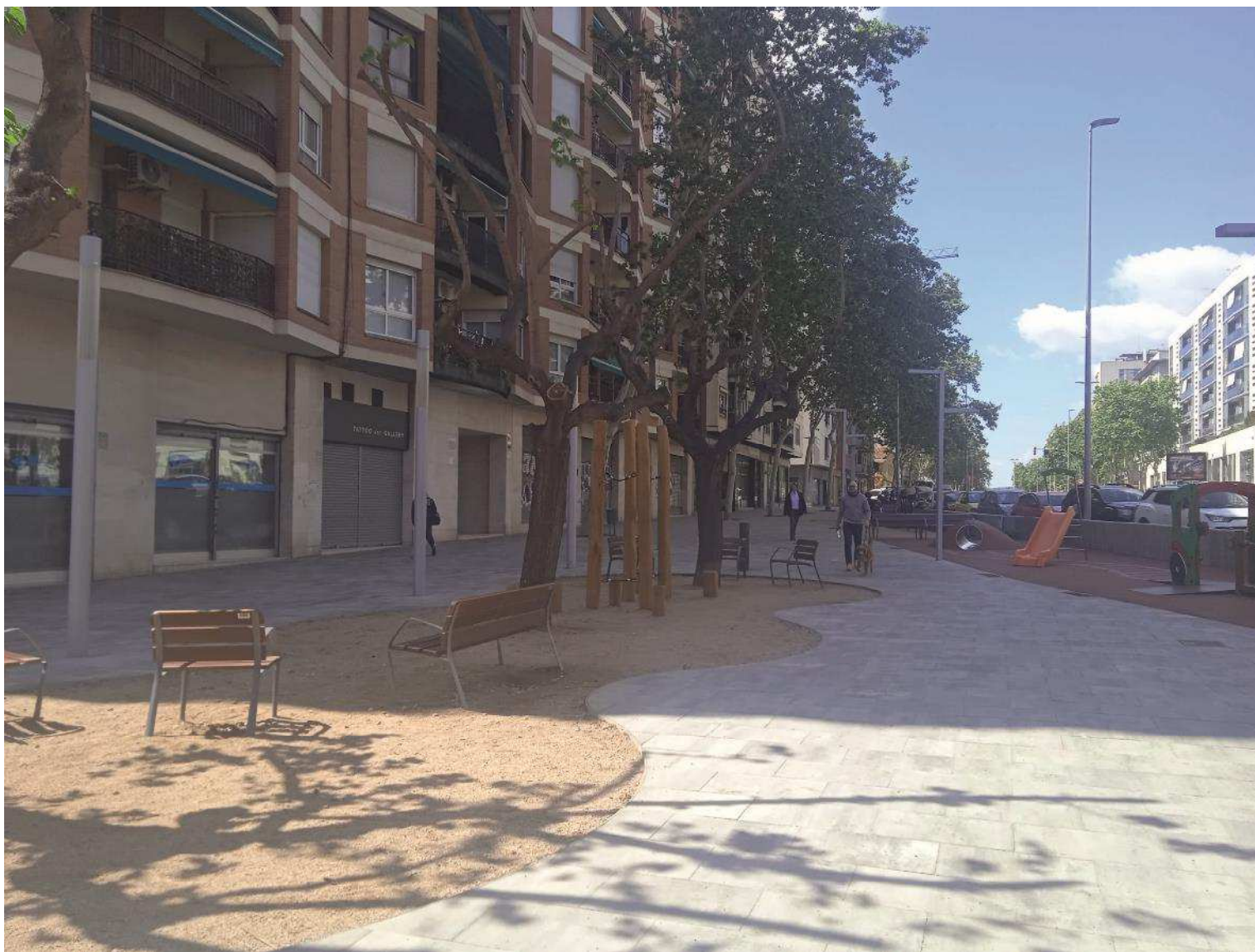
P6_L2-20210927-2 Actuaciones infraestructura Gran Vía-Balcó Ripoll para peatonalizar espacio público y calmar tráfico Nº de expediente: PRTRMU-21-00205
