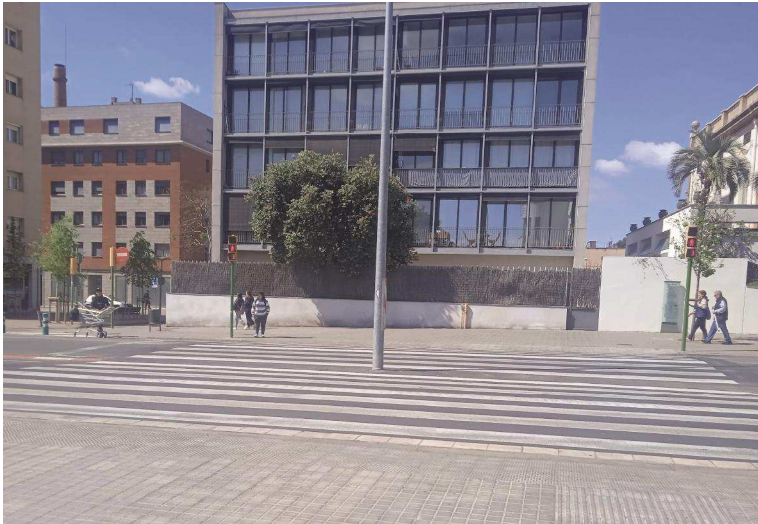
P6_L2-20210927-1 Adecuación zonas e itinerarios peatonales y ciclistas y mejora permeabilidad Gran Vía – Balcó Ripoll Nº de expediente: PRTRMU-21-00205
