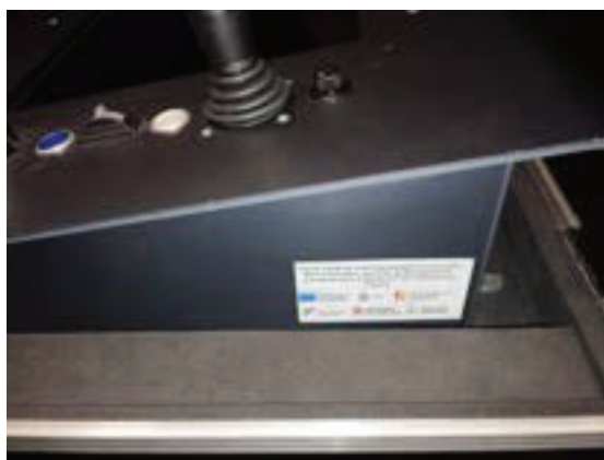
Teatre Principal - Modernització dels sistemes de gestió digital de maquinària escènica (consola de barres)
