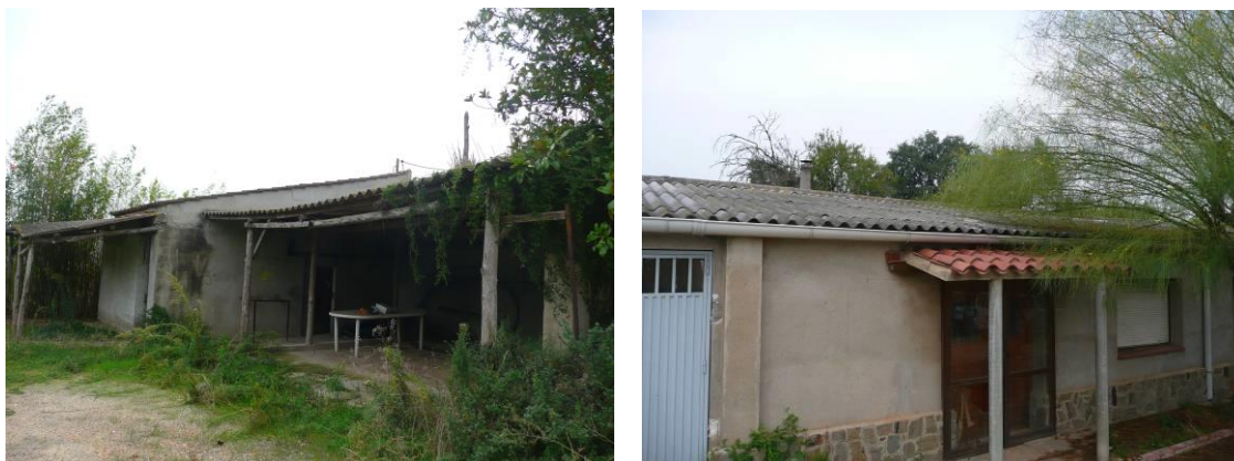
Figura 11. Detall de la construcció existent a la finca de Can Gambús
