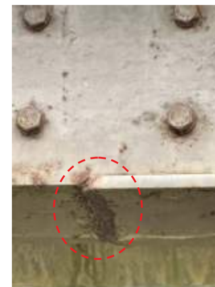
Soldadura tram 1 aigües amunt
