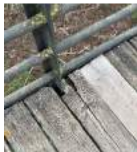
Element trencat paviment
