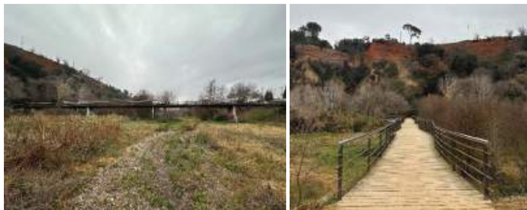
Vista general del pont. Vista lateral i superior respectivament
