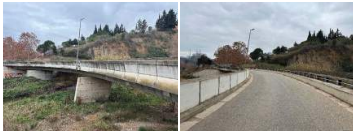
Vista general del pont. Vista lateral i superior respectivament
