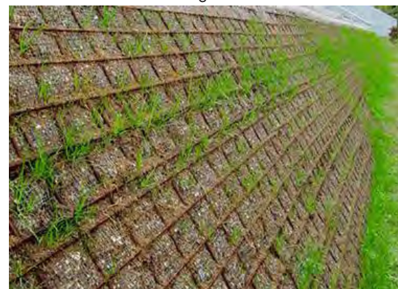
mur verd amb contenció d'emmallat d'acer
