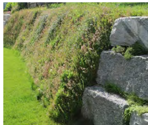
mur verd amb retenció de geo cel·les
