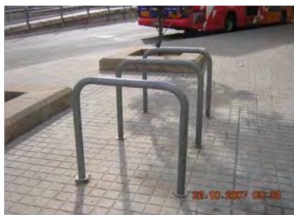
E – U invertida d'acer galvanitzat
