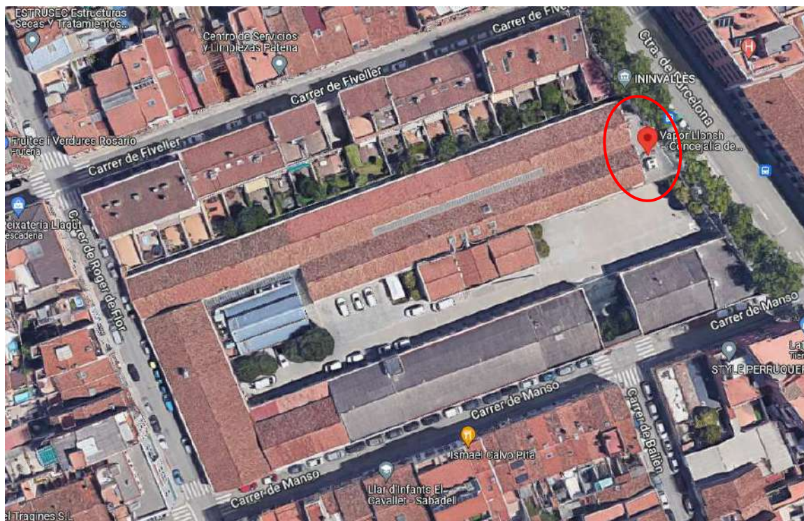
Ubicació de la màquina refredadora
