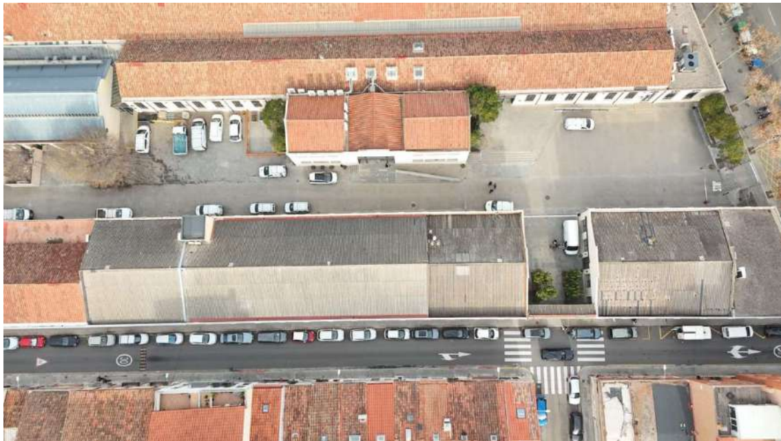
Fig. 21 Vista de la coberta.
