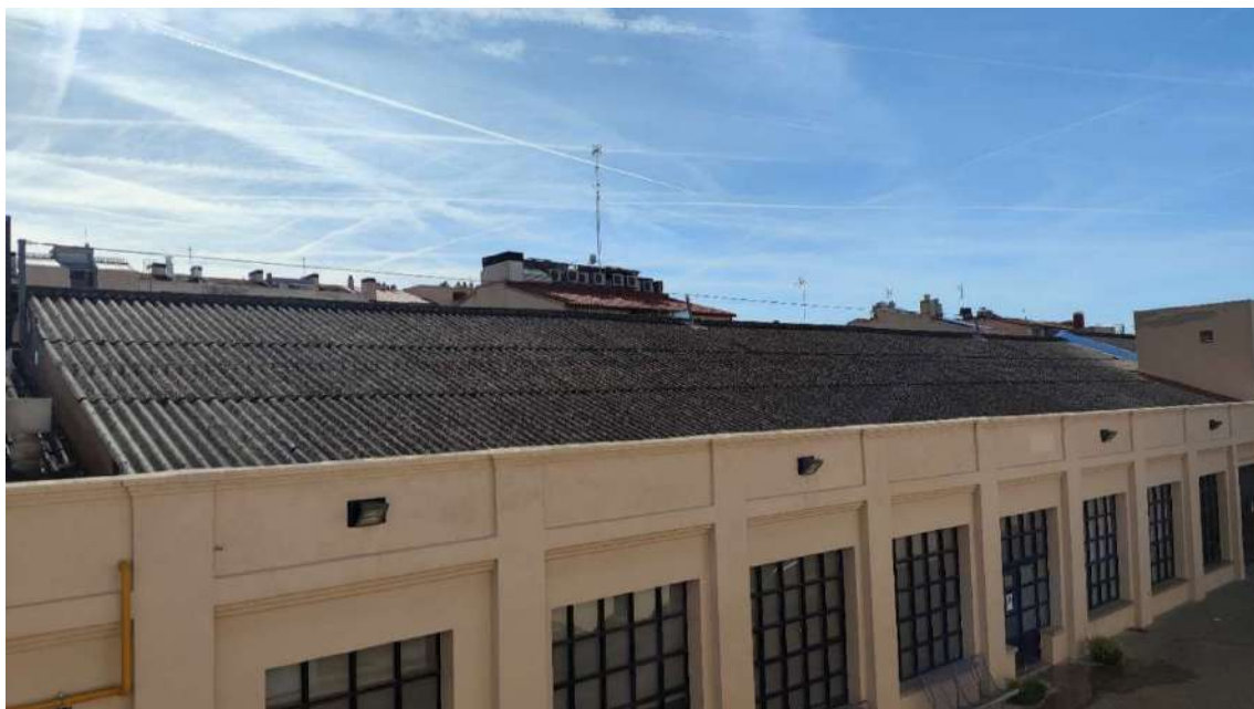
Fig. 22 Vista Nord de la coberta.
