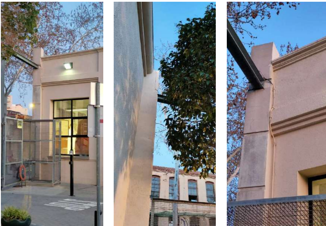
Fig. 25 Conducció de cablejat entre terrasses per sobre estructura metàl·lica existent.
